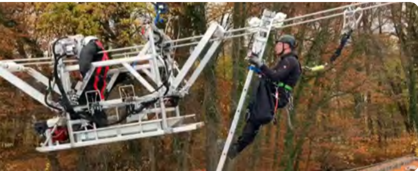
HERANFAHREN AN DEN LEITUNGSFAHRWAGEN
