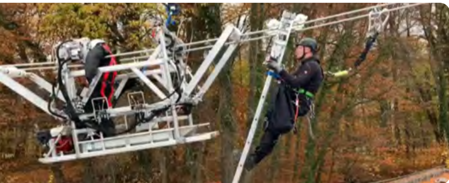
DOJAZD DO WÓZKA LINIOWEGO
