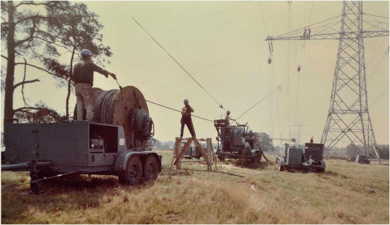
Winde-Bremse WB 1500 von ZECK im Einsatz
