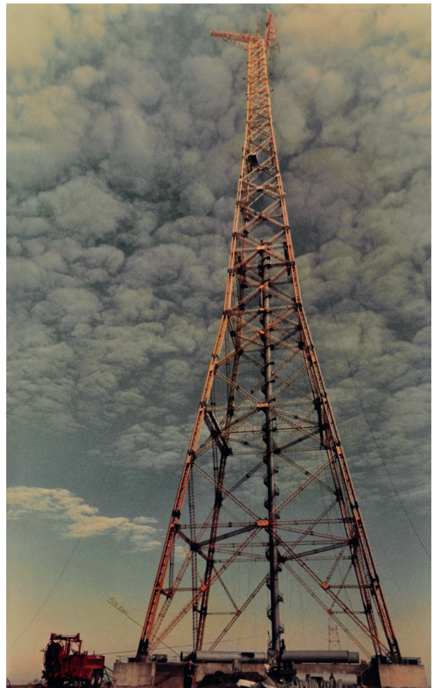
Freileitungsmast der Elbekreuzung mit Wendeltreppe im Innern, 227 m hoch
