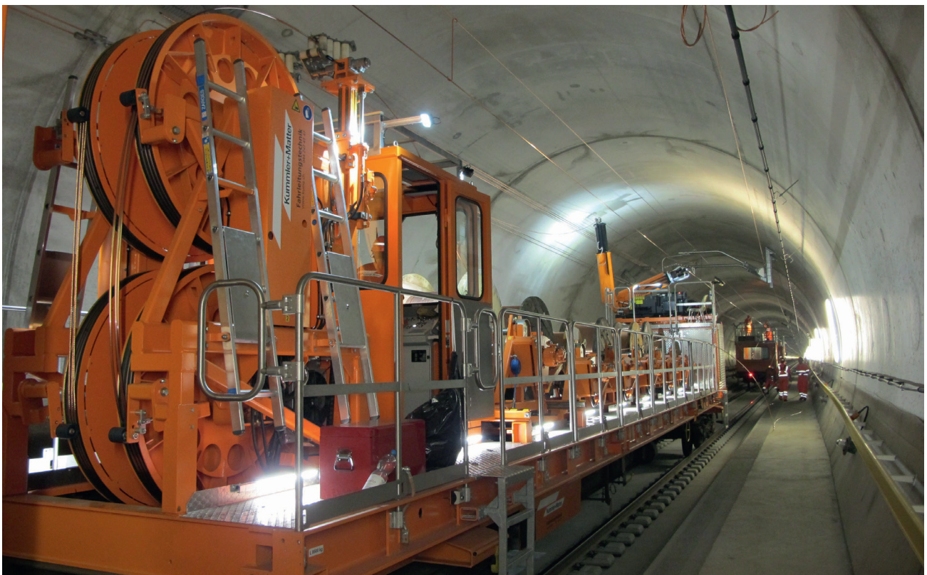
Elektrifizierung des St. Gotthard-Tunnels
