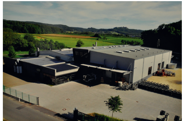
Der Erweiterungsbau in Burgellern 1994/95
